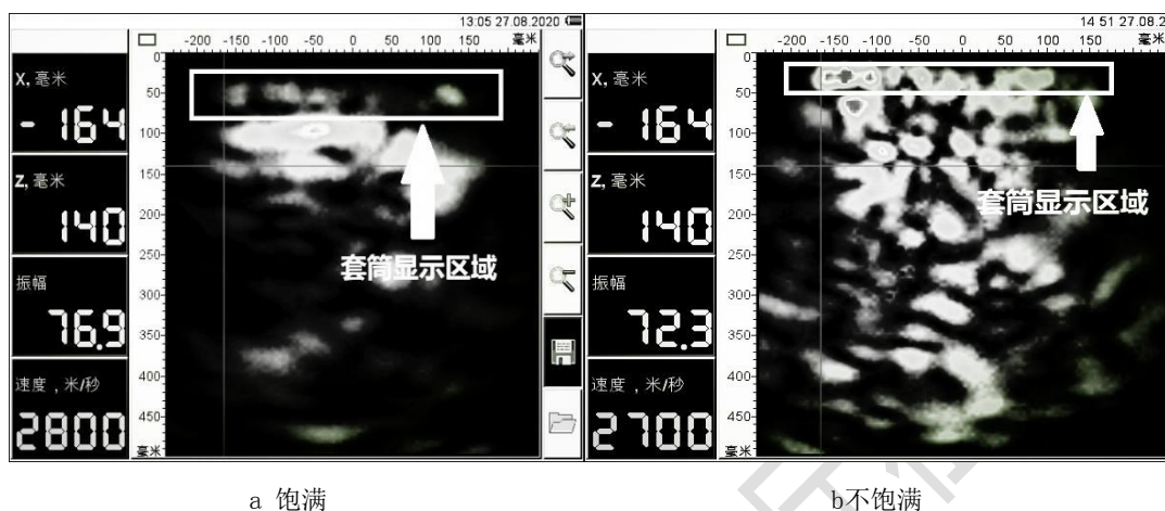
图4.5.3混凝土超声断层扫描套筒灌浆饱满情况
